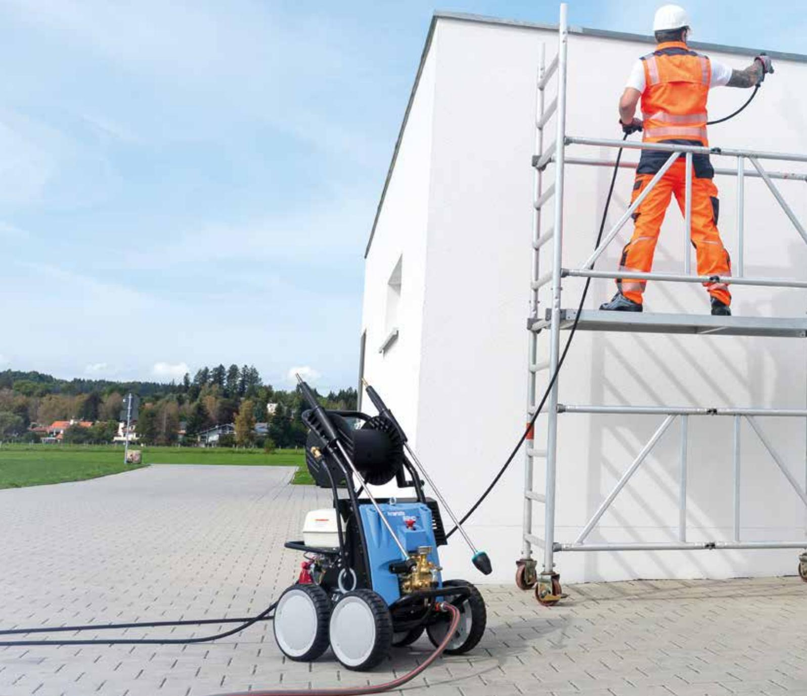
HIDROLIMPIADORAS DE ALTA PRESIÓN CON MOTOR DE COMBUSTIÓN INTERNA
